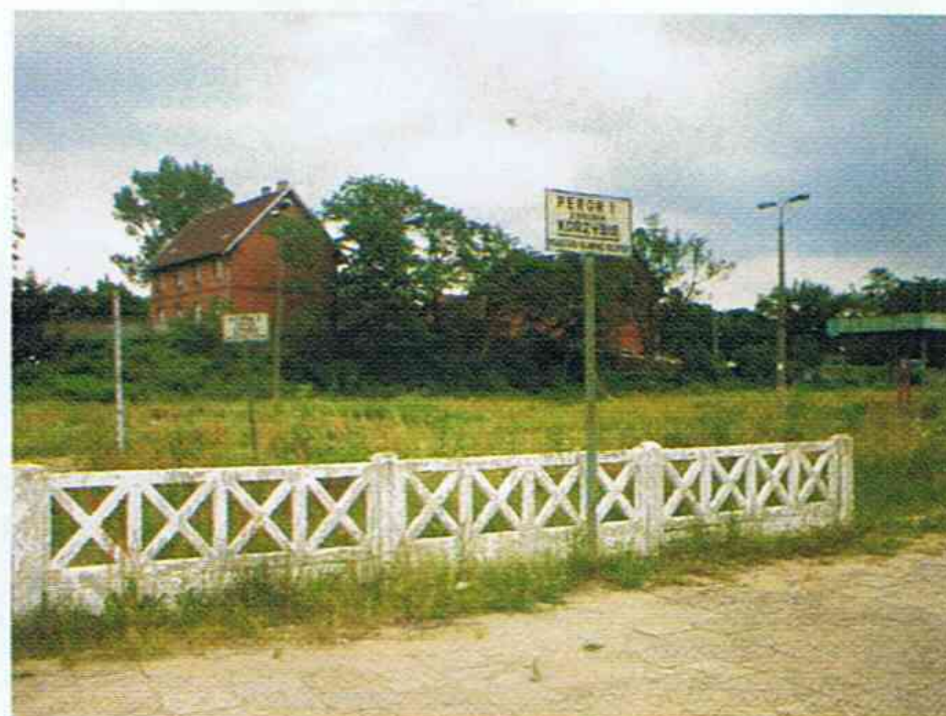
Na zdjęciu - stacja Bytów, a raczej to co z niej zostało.
